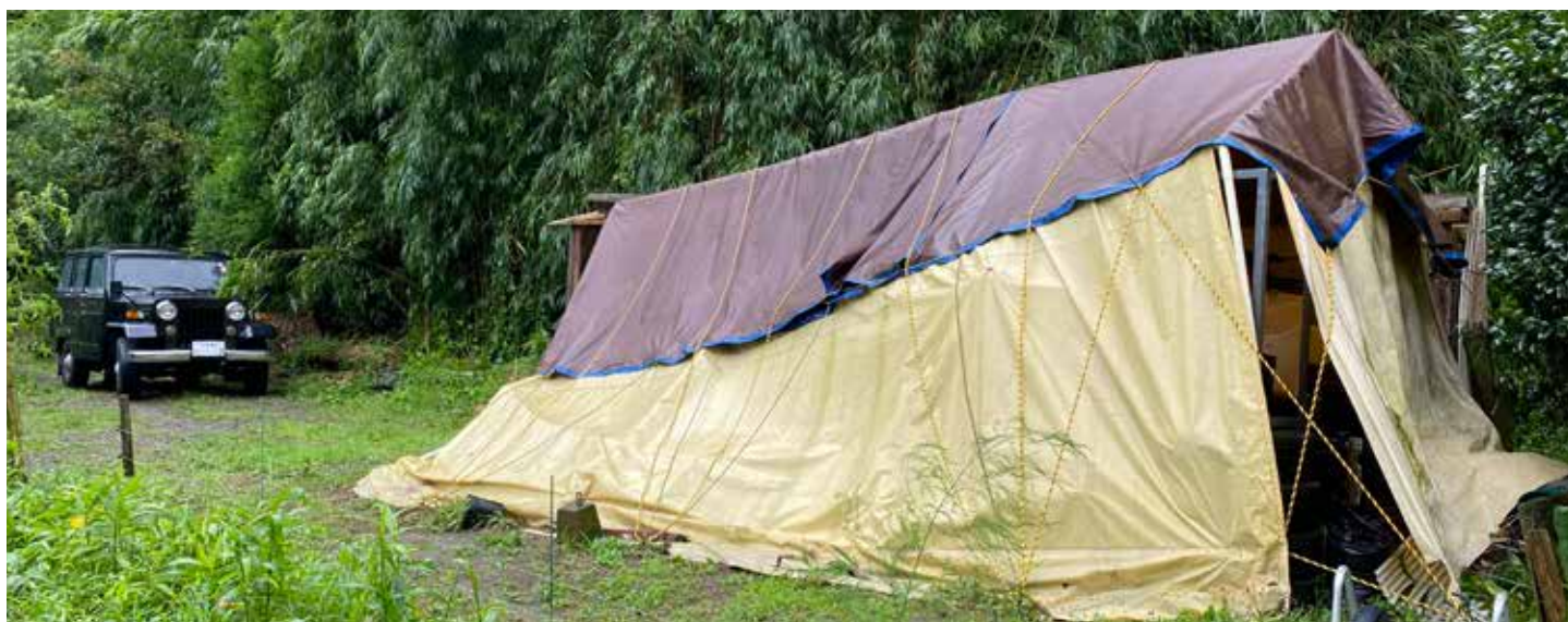
台風 10 号（ハイシェン）の強風で倒壊したテント車庫。（2020 年 9 月 7 日）
